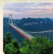
สะพานอ้ายจ้าย
